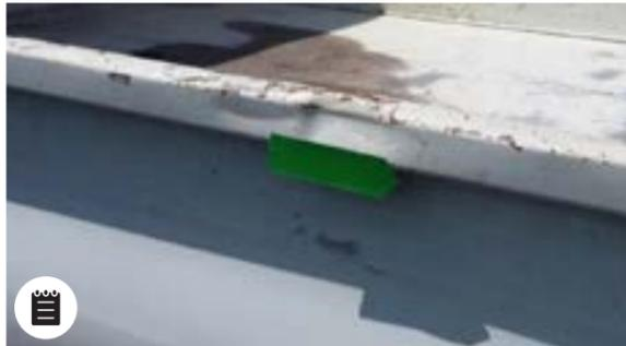
Leichte Kratzer, Schienenverformungen mit Reparaturzeit  $\leq$  1 h
